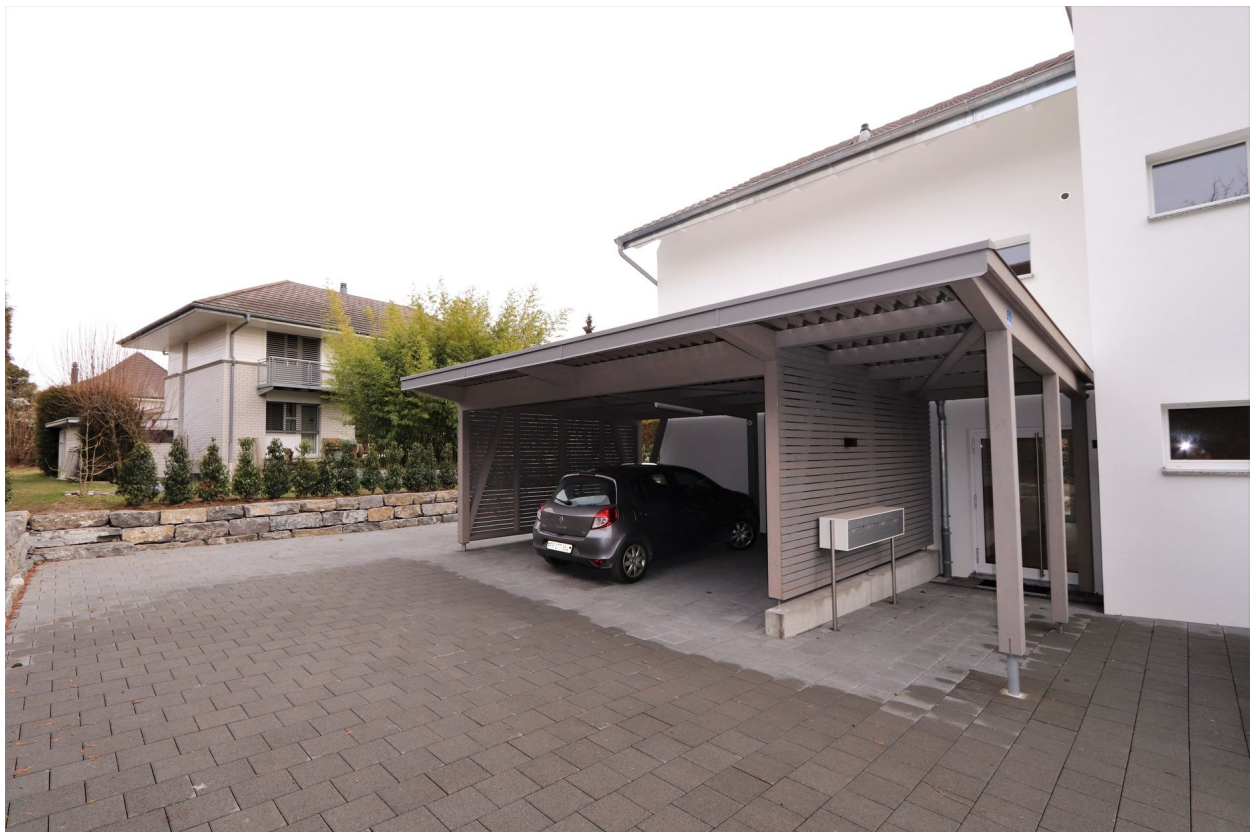
Carport der Dachwohnung
