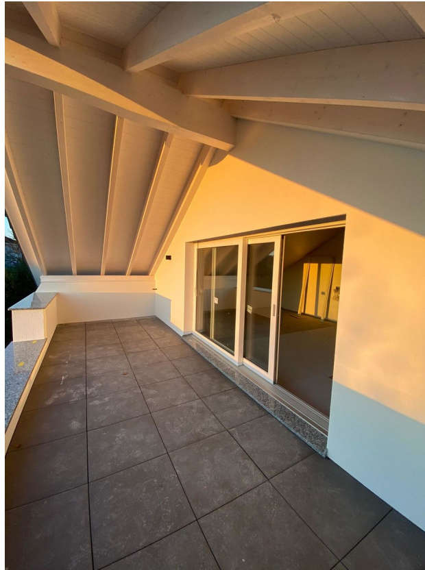
Balkon Wohnzimmer Südwest
